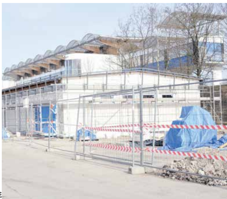
Budowa nowych toalet na tyłach trybuny zachodniej wznoszonych kosztem 1,8 miliona złotych
